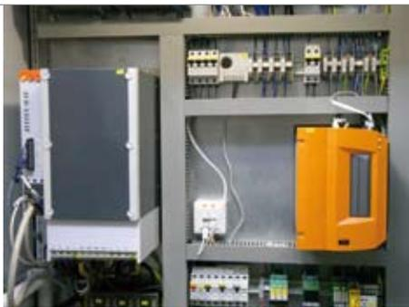
**Druck- bzw. Volumenstromregelung laufen direkt am Acopos-Servoumrichter (links), die übergeordnete Maschinensteuerung ist nicht belastet.**
