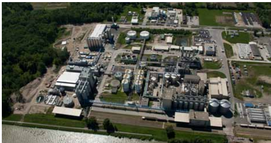
Die Stärkegewinnung aus Weizen und die Erzeugung von Bioethanol im Agrana-Werk Pischelsdorf erfolgt unter der Kontrolle einer durchgängigen Gesamt-Softwarelösung von Siemens mit SIMATIC PCS 7, UNILAB und SIMATIC IT.
