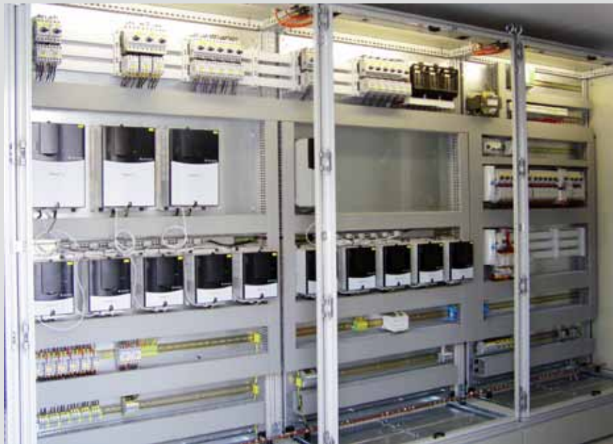
Die Leistung von ATe-s umfasst neben der Planung auch den Schaltschrankbau sowie die Inbetriebnahme vor Ort und reicht bis zu Konzepten für die Instandhaltung.
