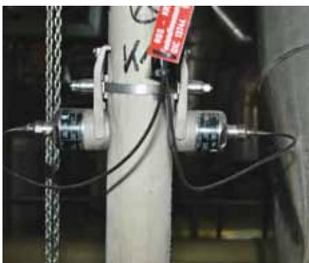
**links** Die entscheidende Verbesserung der Prozessstabilität brachte die Regelung der Salzzufuhr durch Messung des Feststoffanteils mit Ultraschall-Durchflussmesswandlern Proline Prosonic Flow 93P von Endress+Hauser.
