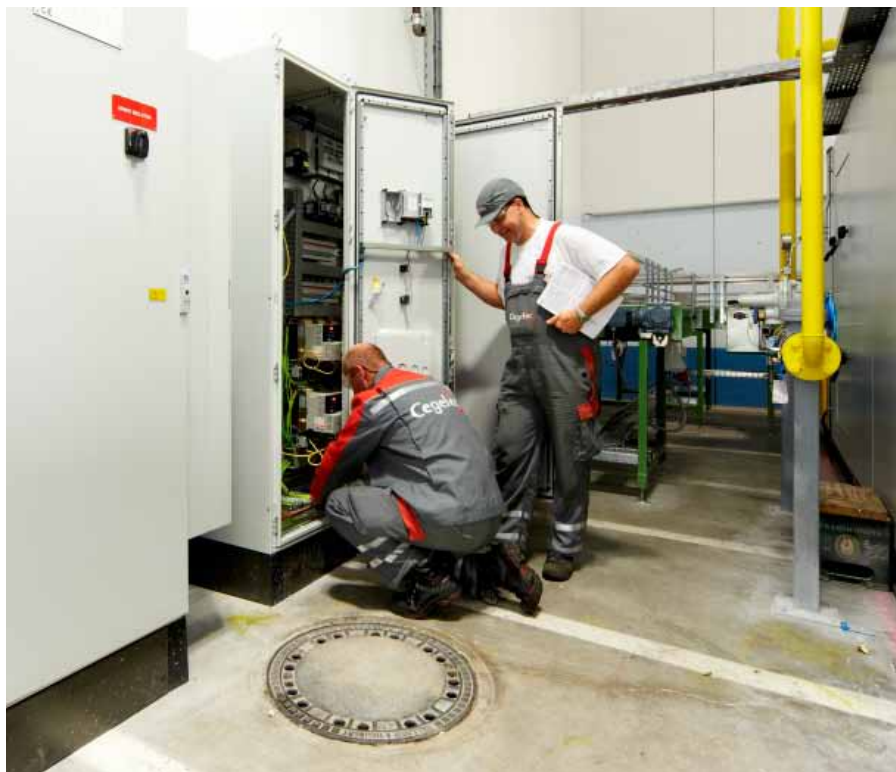
oben Für die Wartung der Energieversorgungs-, Stromverteilungs- und Schaltanlagen bedient sich Rexam seit über 20 Jahren häufig der Leistungen der Cegelec GmbH.
