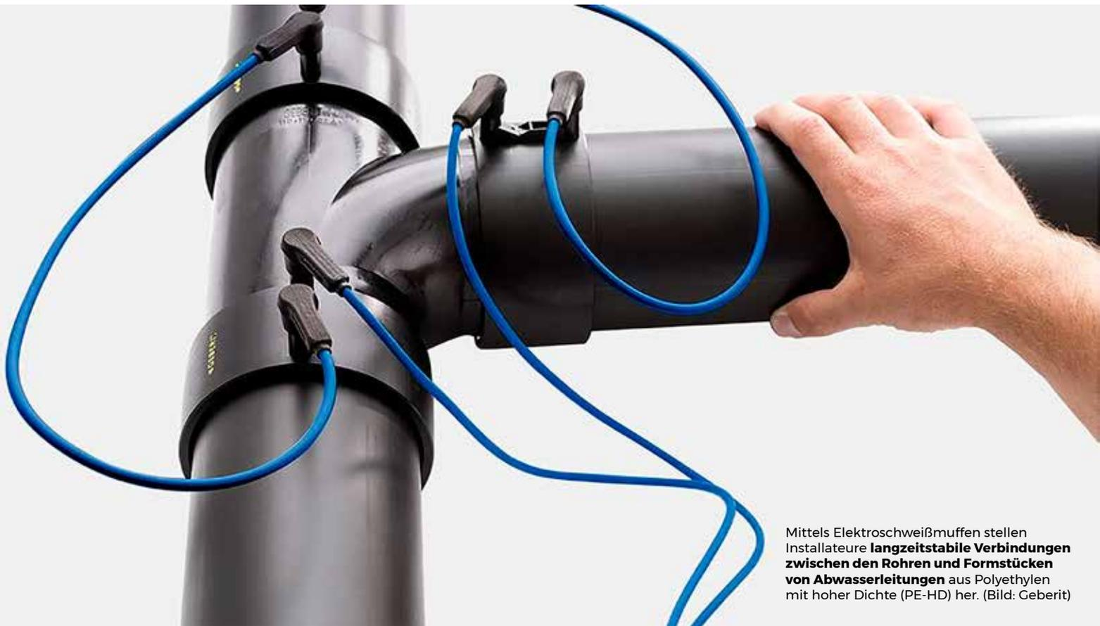
Mittels Elektroschweißmuffen stellen Installateure **langzeitstabile Verbindungen zwischen den Rohren und Formstücken von Abwasserleitungen** aus Polyethylen mit hoher Dichte (PE-HD) her. (Bild: Geberit)
