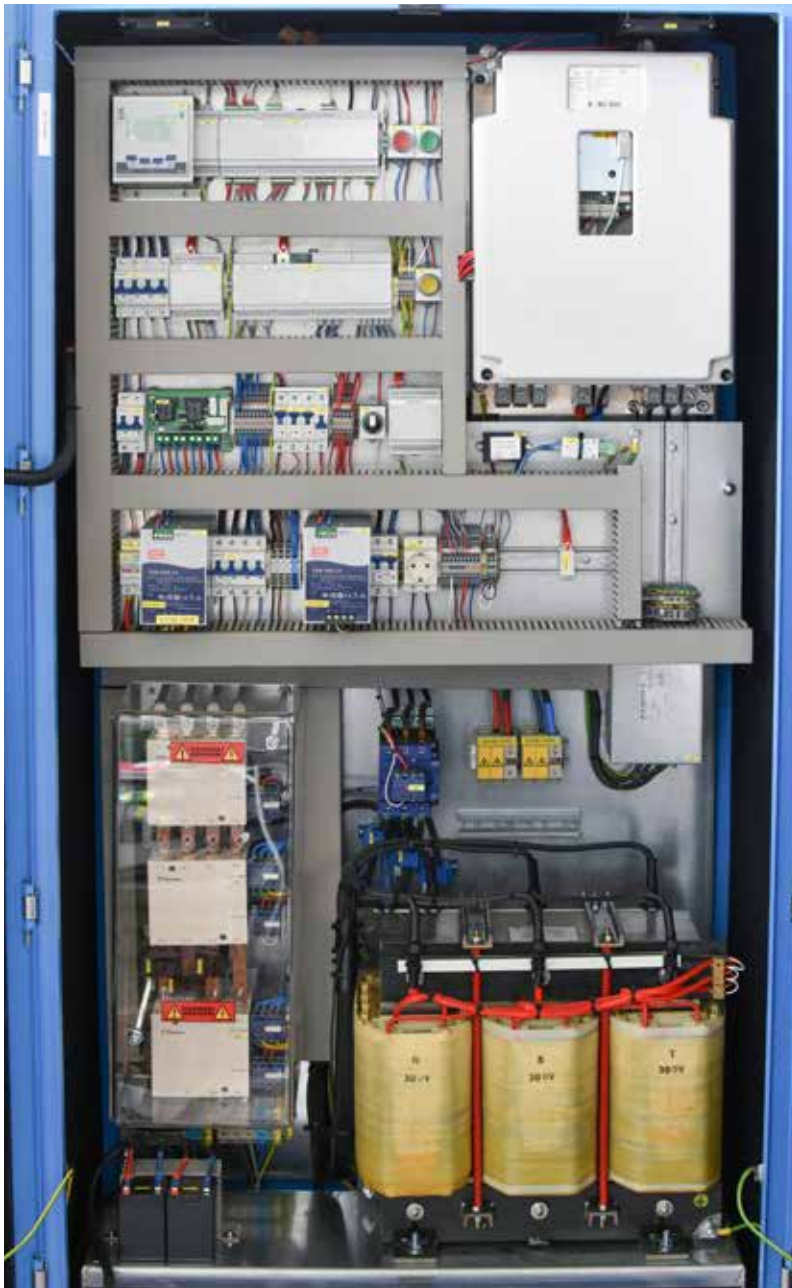
Lösungen von Xelectrix Power haben einen hohen Eigenentwicklungsanteil . Der Schaltanlagenbau erfolgt überwiegend bei einem ausländischen Partnerunternehmen.
