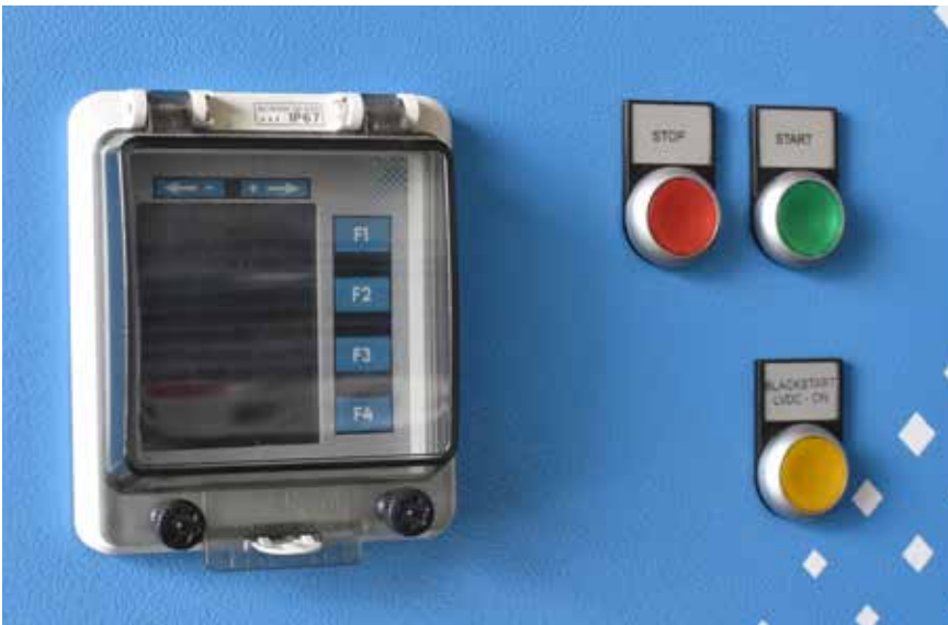
Die Entwicklung der Lösungen im Haus umfasst die Batteriezellen und Leistungselektronik ebenso wie die Steuerung samt Bedienpanel.
