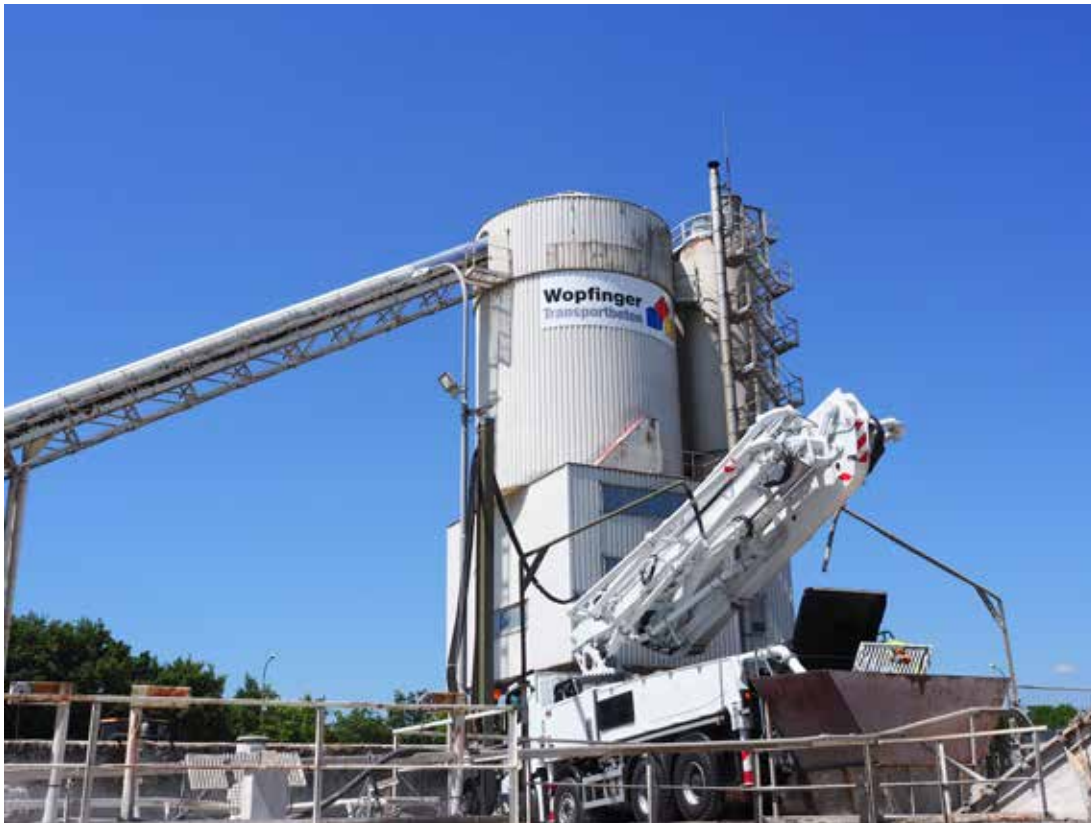
Im Transportbetonwerk Nussdorf ob der Traisen erzeugt Wopfinger Beton unterschiedlichster Güteklassen, darunter auch Ökobeton. Die Vorprodukte werden im Freien gelagert und sind daher der Witterung ausgesetzt. (Bild: Wopfinger Transportbeton)
