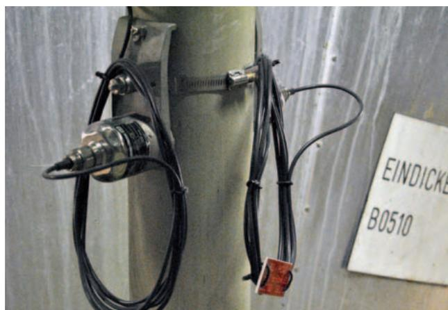
Mit zwei Schallgebern bzw. -empfängern DDU18 messen die Geräte die Schallgeschwindigkeit des aus den Eindickern kommenden, crushed-ice ähnlichen Salzbreis.
