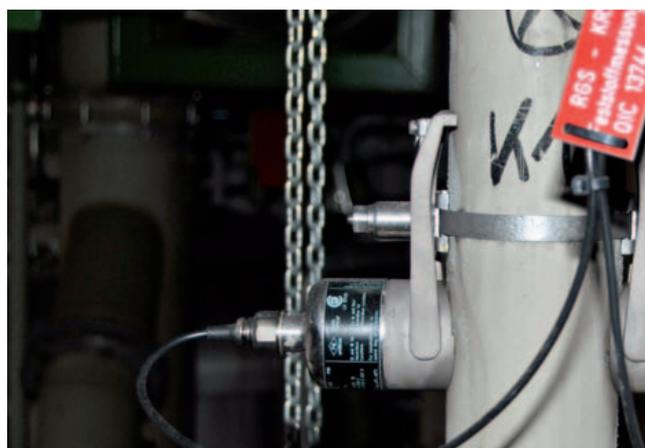
Die entscheidende Verbesserung der Prozessstabilität brachte die Regelung der Salzzufuhr durch Messung des Feststoffanteils mit dem Proline Prosonic Flow 93P.
