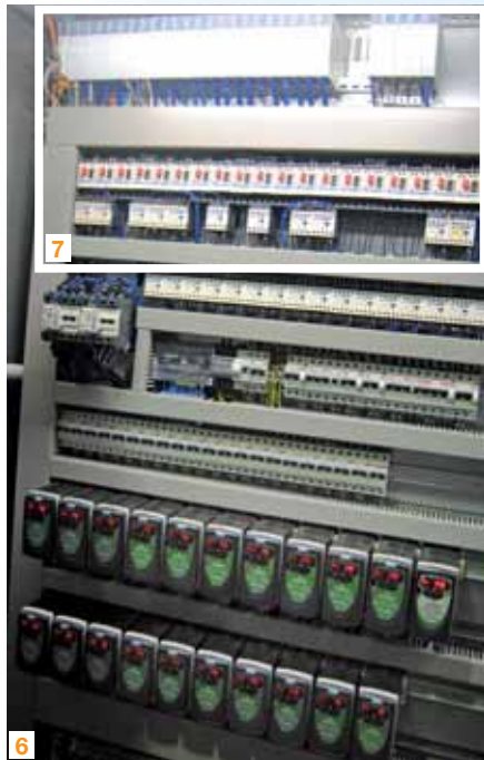
6 Übersicht im Schaltschrank: Die CPU des Sigmatek C-DIAS Systems steuert ca. 300 I/Os und übernimmt die Navigation der Frequenzumrichter für ca. 35 AC-Motoren.
