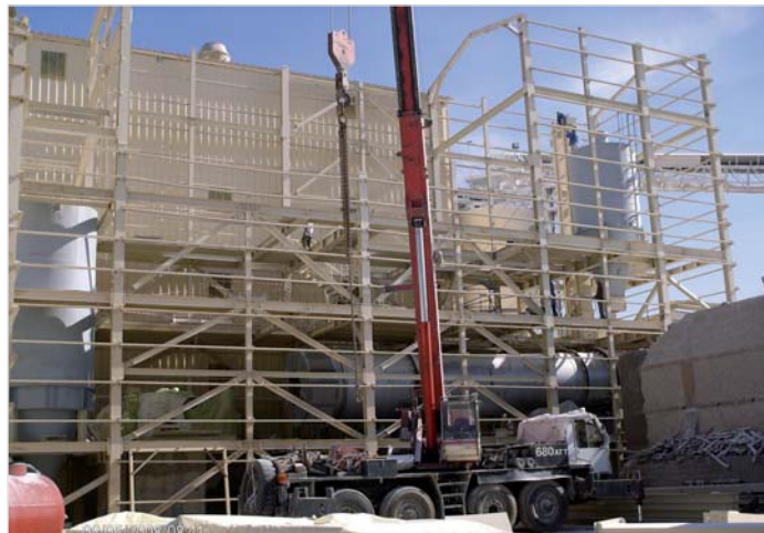
Ein Qualitätsbeweis von Arnetzeder engineering und von Solid Edge: Die Anlage wurde ohne Rückfragen auf Basis der per Email versendeten Pläne in Afrika montiert.
