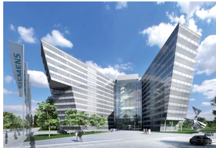
Mit dem Bau der Siemens City Vienna setzte Siemens Österreich das weltweit größte Immobilienprojekt des Siemens-Konzerns um.
