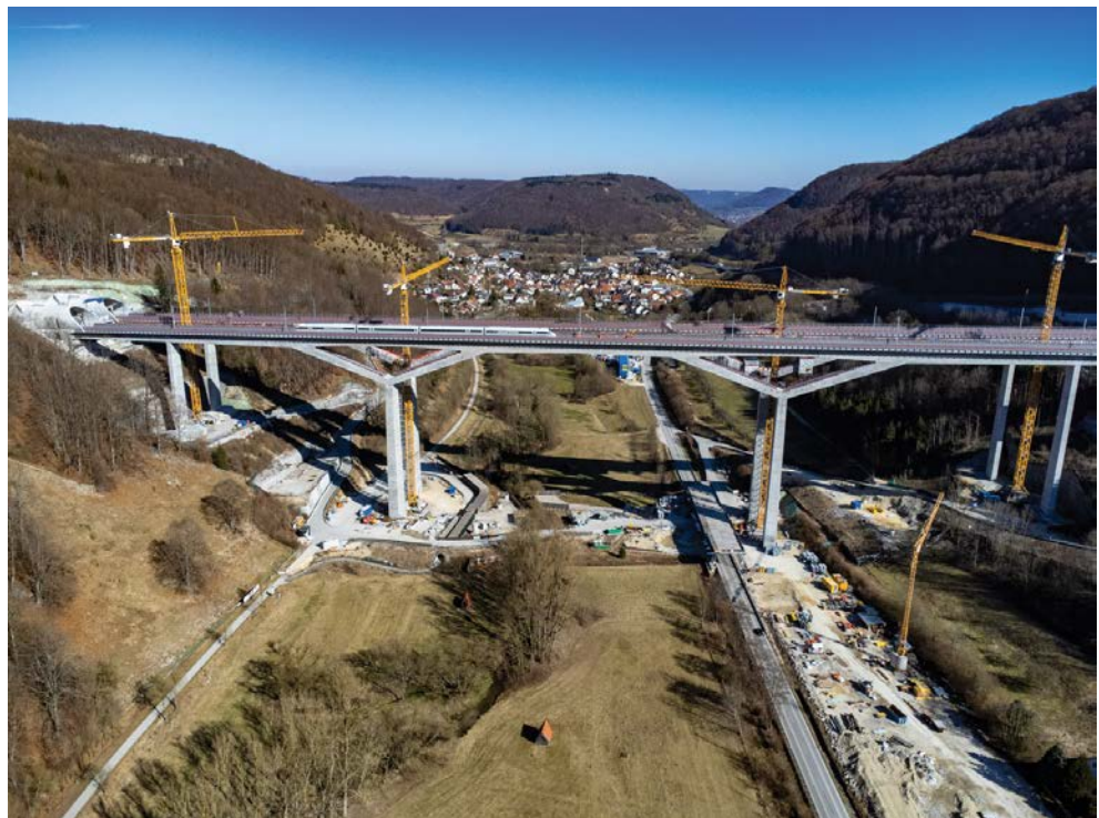
Die Doppelbrücke über das Filstal in Süddeutschland ist Teil des Abschnitts Stuttgart-Ulm der europäischen Hochgeschwindigkeits-Bahnstrecke zwischen Paris, München, Wien, Bratislava und Budapest.
