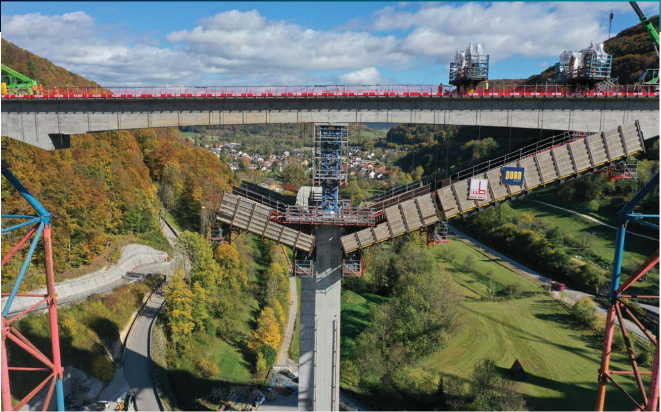
Die teilintegrierten Brücken werden von schlanken, Y-förmigen Pfeilern mit flachen Streben getragen, die am Ende des Bauprozesses betonierte und nahtlos mit den Trägern verbunden wurden.
