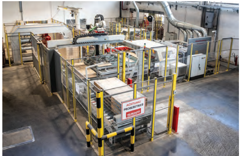
In der Förderanlage wird ein Materialfluss geteilt, bei dem sich die Bretter mit 20 bis 100 Metern pro Minute bewegen
