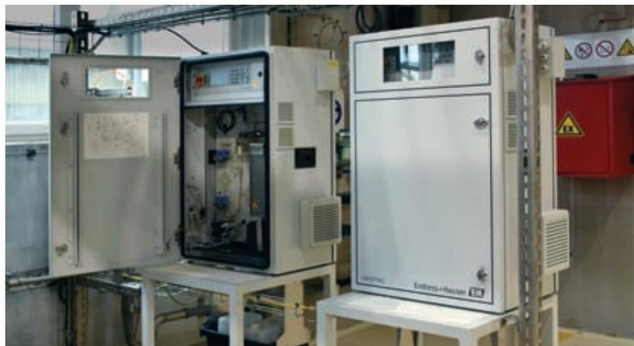
**Oben:** Die moderne Kesselanlage für die Dampferzeugung braucht für einen zuverlässigen, unterbrechungsfreien Betrieb über lange Zeiträume hinweg besonders reines Wasser. Deshalb werden vor allem die Kondensatleitungen mit Leitfähigkeitssensoren »Condumax CLS15« und TOC-Analysatoren »TOCII CA72TOC« von Endress+Hauser überwacht.
