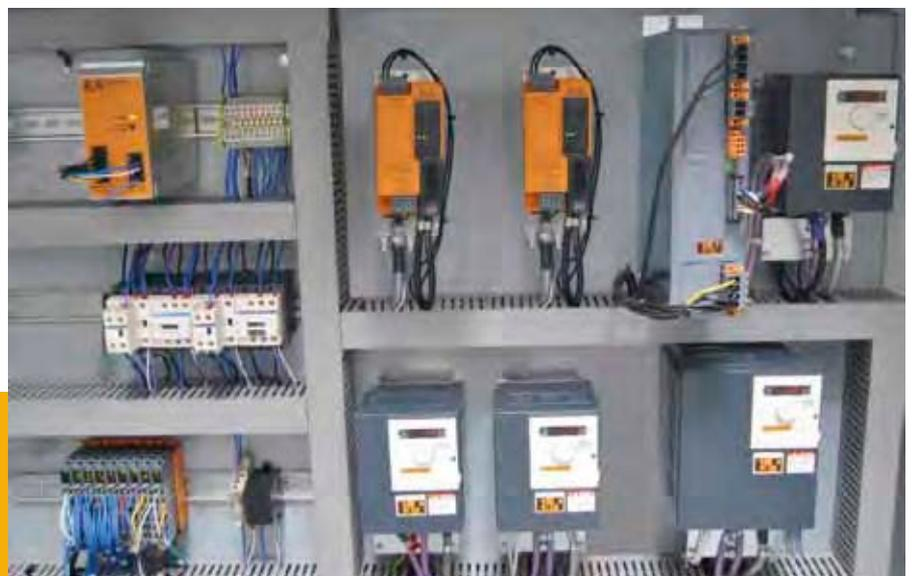
Viel orange Übersichtlichkeit im Schaltschrank: Vom 24V Netzteil und der 80V Gleichspannungsversorgung für die Schrittmotoren über die Frequenzrichter ACOPOSinverter zur Schrittmotoransteuerung ACOPOSmicro X20 I/O Modulen.
